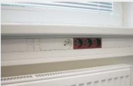
Exemplu de montaj al canalului de parapet PK 120X55 D.
